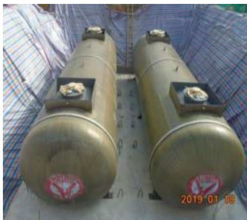
胶水罐区地面进行硬化及防渗处理
