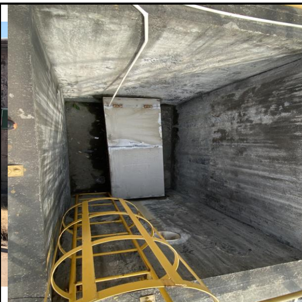
生活污水总排口
