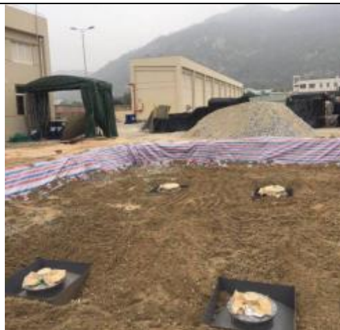
胶水罐区用沙填装
