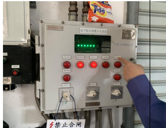
胶水储罐配备安装的泄漏检测预警装置
