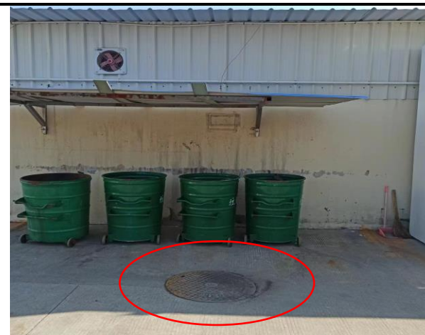
危废仓库（收集池）
