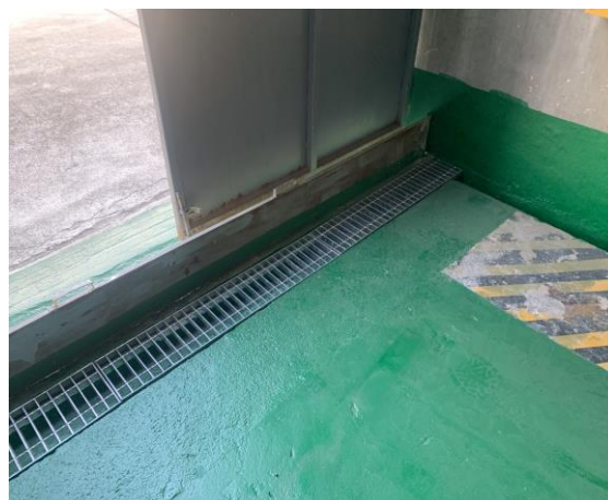
危废仓库（防腐防渗、导流沟及围堰）
