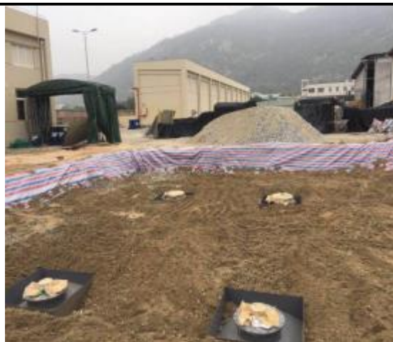
罐区用沙填装
