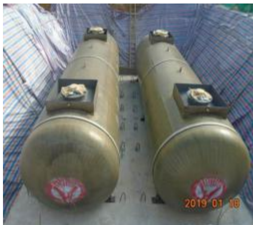
罐区地面进行硬化及防渗处理
