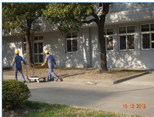
雨水排放口堵漏
